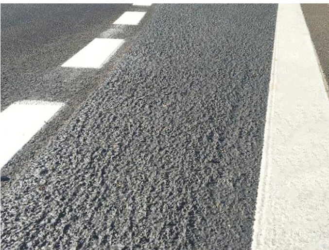
Abb. 3: Dank seiner extremen Griffigkeit sorgt der Strukturbelag WeTraffic 493 für verkürzte Beschleunigungs- und Bremswege auf Ab- und Zufahrten.
