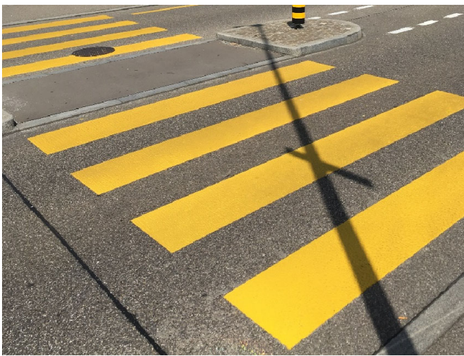
Abb. 4: Die lichtreflektierende Rollmarkierung WeTraffic 497 ist in Gelb und Weiß zertifiziert – sie wird gerne für die Gestaltung von Zebrastreifen verwendet.
