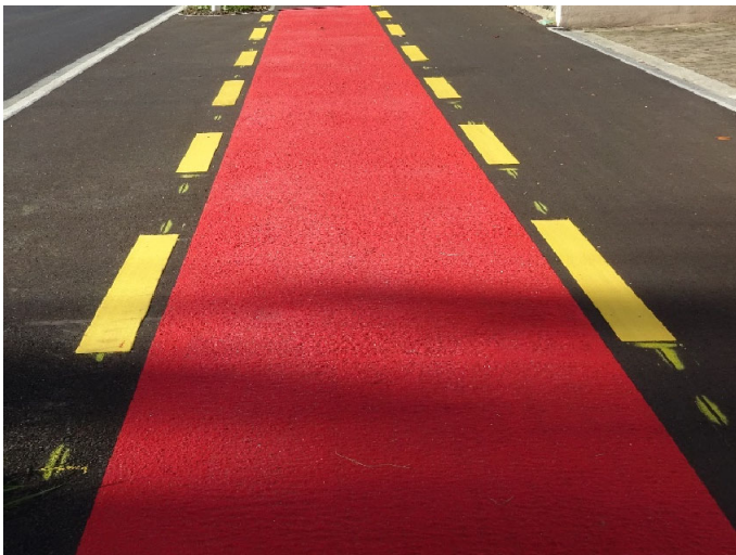
Abb. 6: WeTraffic 496 BX eignet sich für Anwendungen im Innen- und Außenbereich sowie in Fußgängerunterführungen.
