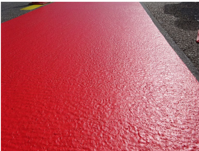
Abb.1: WeTraffic 491 wird auf Park- und Vorplätzen sowie zur eindeutigen Markierung von Radwegen und Fußgängerpassagen eingesetzt.
